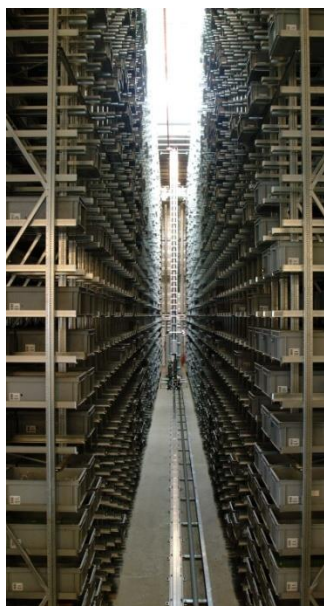
Autom. Kleinteilelager Phoenix Contact GmbH & Co. KG
